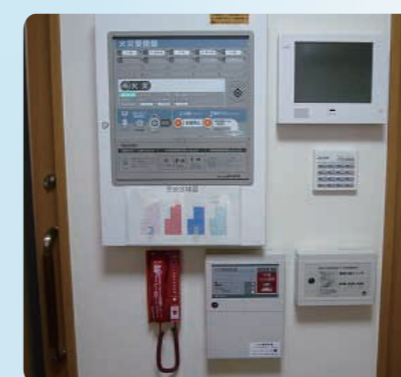
自動火災通報装置
